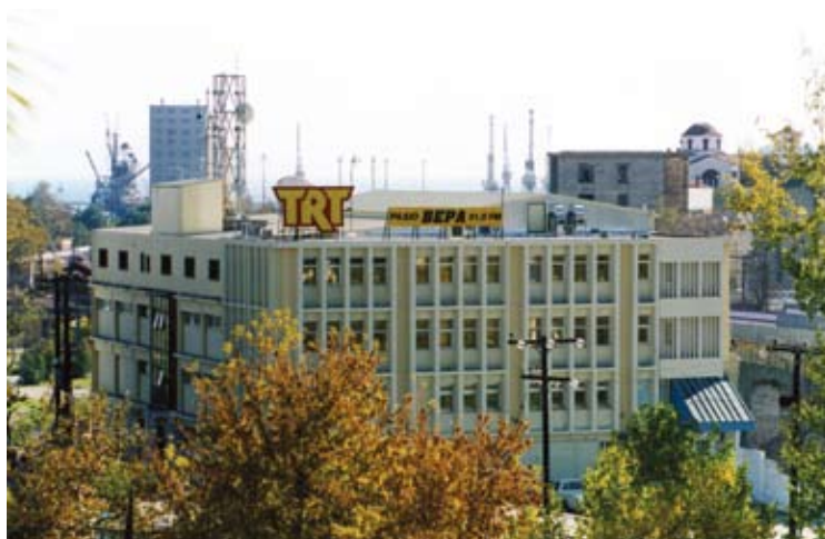
Το κτίριο όπου στεγάζεται ο Τ/Σ TRT στον Βόλο
